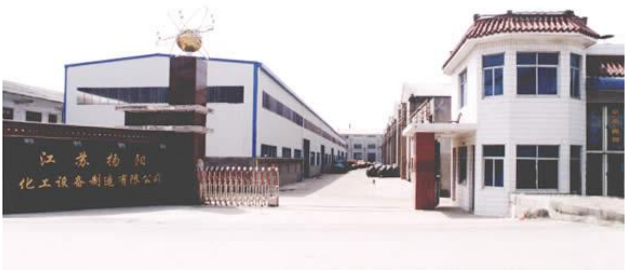
江苏扬阳老厂区
